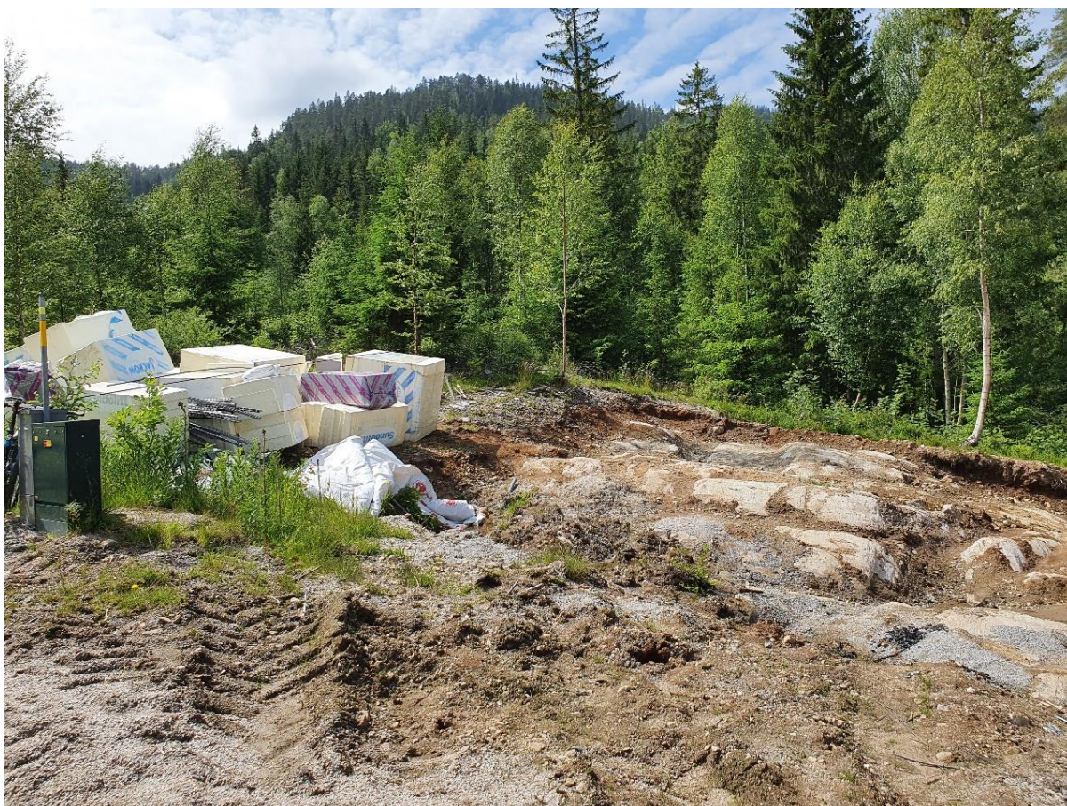
Figur 8: Utgravd tomt i planområdet. Synlig fjell under tynt dekke. Bilde tatt på befaring 25.06.2021
