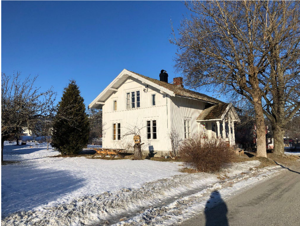
Våningshuset på Kamperhaug
