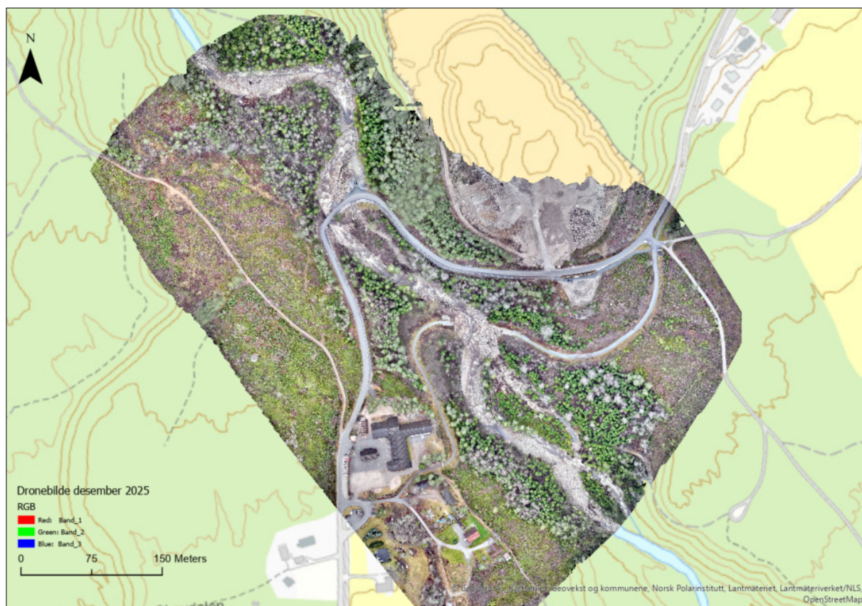
Figur 1-2. Foto fra drone av Juvsså, desember 2025. Vegbrua på Eikavegen står mens gang- og sykkelbrua røyk under flommen.
