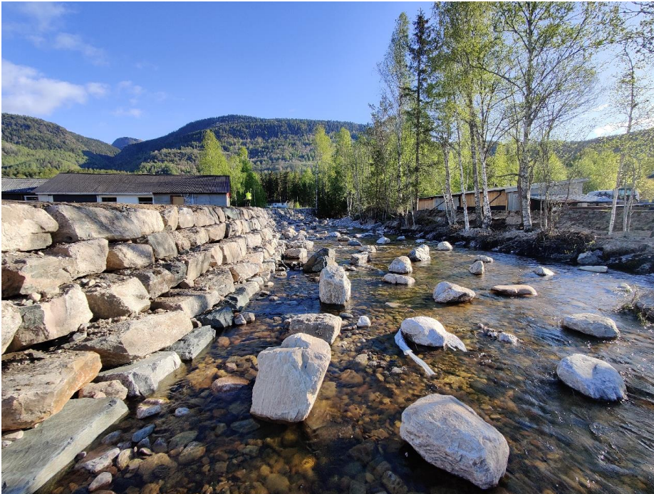
Figur 5: Steiner plassert oppstrøms bruene.
