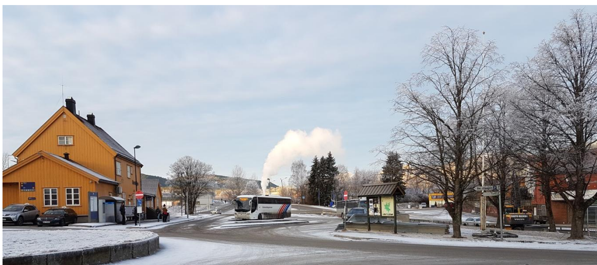
Figur 2 Stasjonsbygningen med taxiholdeplass foran denne, bussterminal og kiss&ride. (Kilde: Sigrun D. Ganz)
