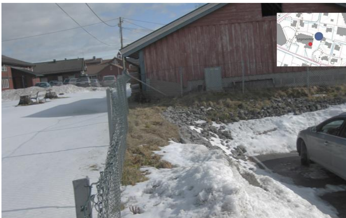
Figur 7-8. Bildene biser dagens situasjon i foreslått trasé for ny forbindelse Hellandvegen - Gamleveg.
