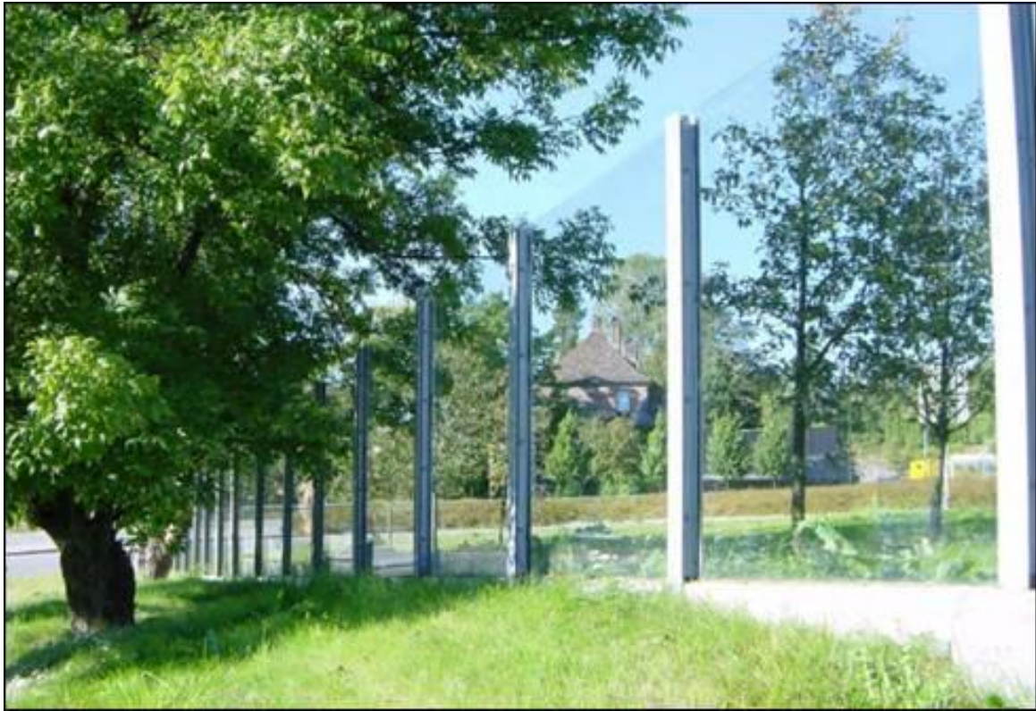
Figur 4-9: Støyskjerm med glassfelt tilknyttet Blommenholmkrysset. Bildet er hentet fra "Støyskjermkatalog til Statens vegvesen".
