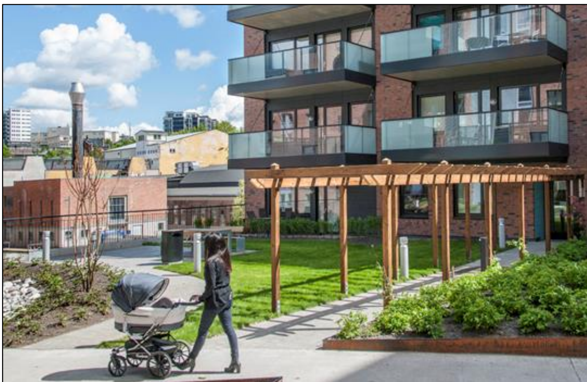
Figur 4-10: Støyskjermende glassrekkverk på balkong. Bildet er hentet fra Kværnerbyen.
