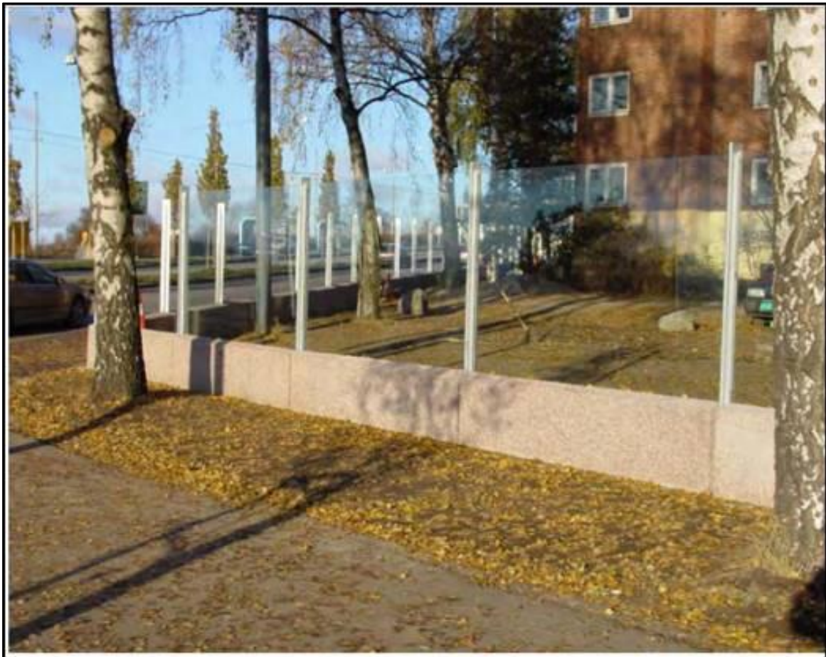
Figur 4-8: Støyskjerm med glassfelt ved Sinsebyens bebyggelse i Oslo. Bildet er hentet fra "Støyskjermkatalog til Statens vegvesen".
