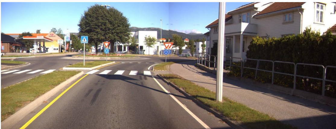
Figur 3: Østfra ved rundkjøring mot Stasjonsvegen (Foto: Statens vegvesen)
