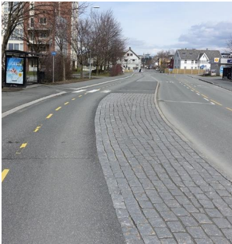
Figur 28: Ensidig sykkelveg med fortau i Trondheim (Foto: Trond Berget, Asplan Viak)
