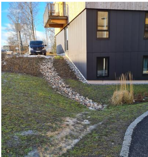
Figur 13: Overvann ledes på terreng i nedsenket grøntområde. Foto: Jan Inge Rygh.
