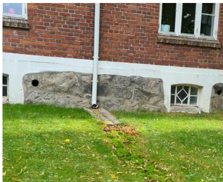
Figur 11: Takvann ledes ut på terreng/grøntområde. Foto: Jan Inge Rygh.
