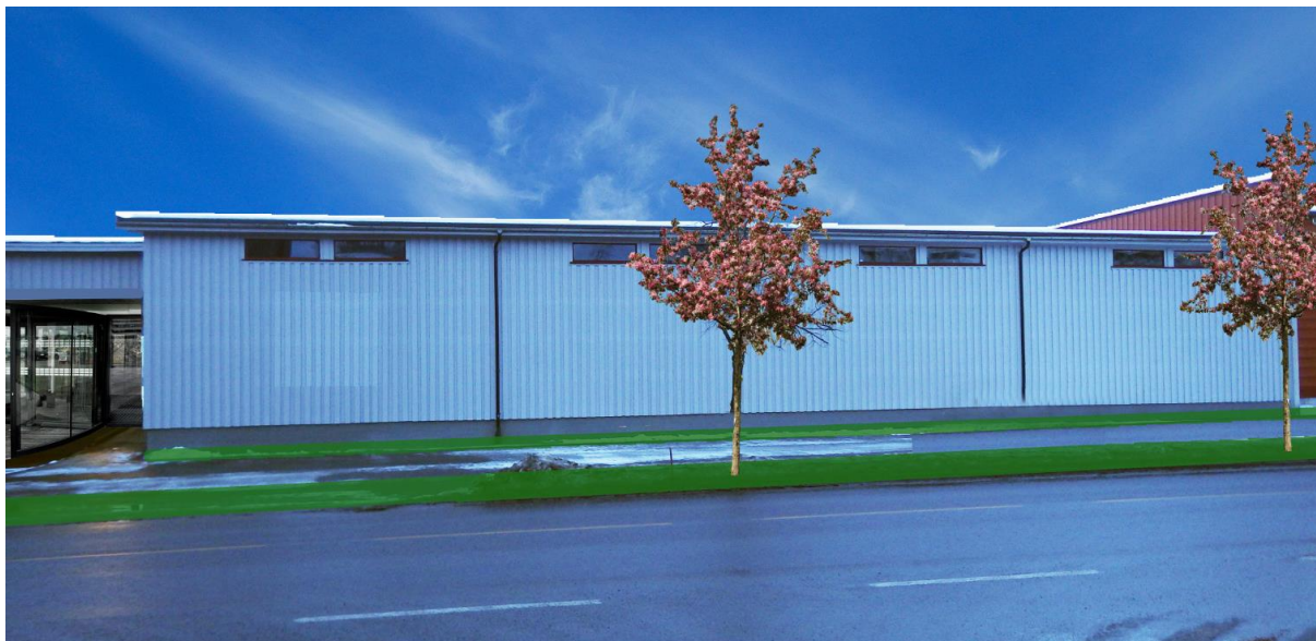
Figur 5.11 Fruktlageret med nytt inngangsparti, ett nytt strøk maling og grønne rabatter med prydepletrær langs Gvarvgata.
