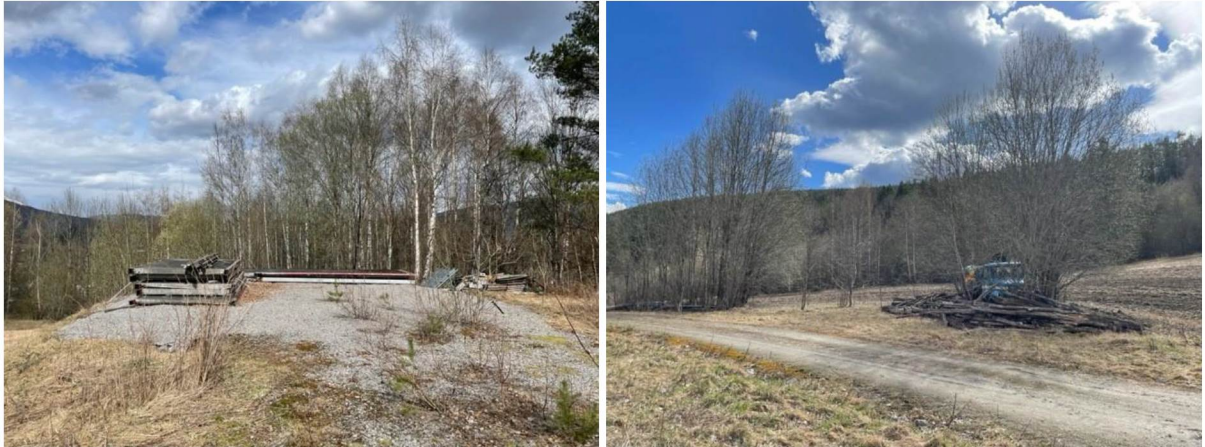
Figur 4: Foto av eksisterende forhold på eiendommen, april 2024.
