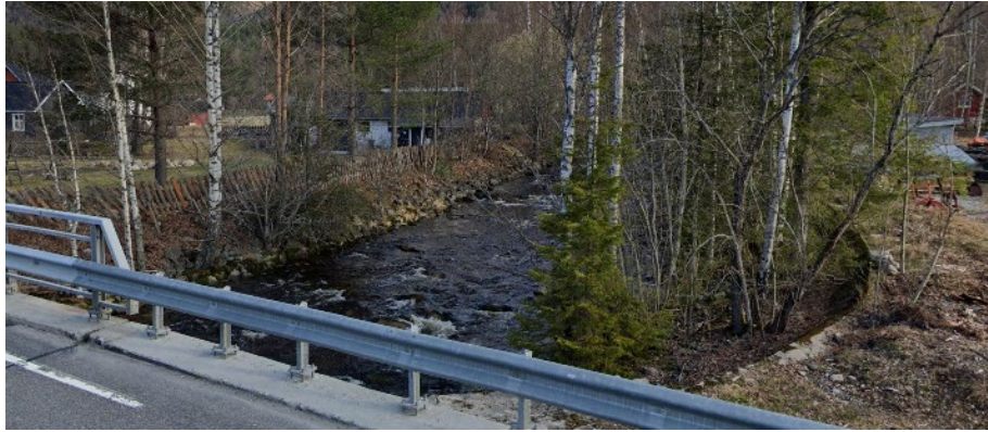
Figur 27: Elva Bjønndøla før flaumen i 2024 (Google Street View, henta 2025).
