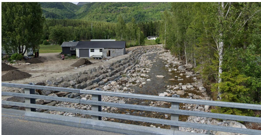
Figur 28: Elva Bjønndøla etter flaumsikringstiltaka blei bygd i 2024 (Google Street View, henta 2025).
