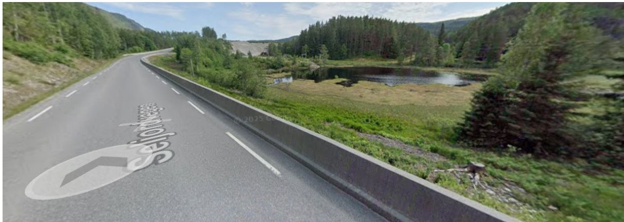
Figur 37: Betongrekkverk langs Rv. 36 hindrar avrenning av overvatn frå veg mot drikkevasskjelda ved Herretjønn. I bakgrunnen kan ein skimte Herremoen grustak.
