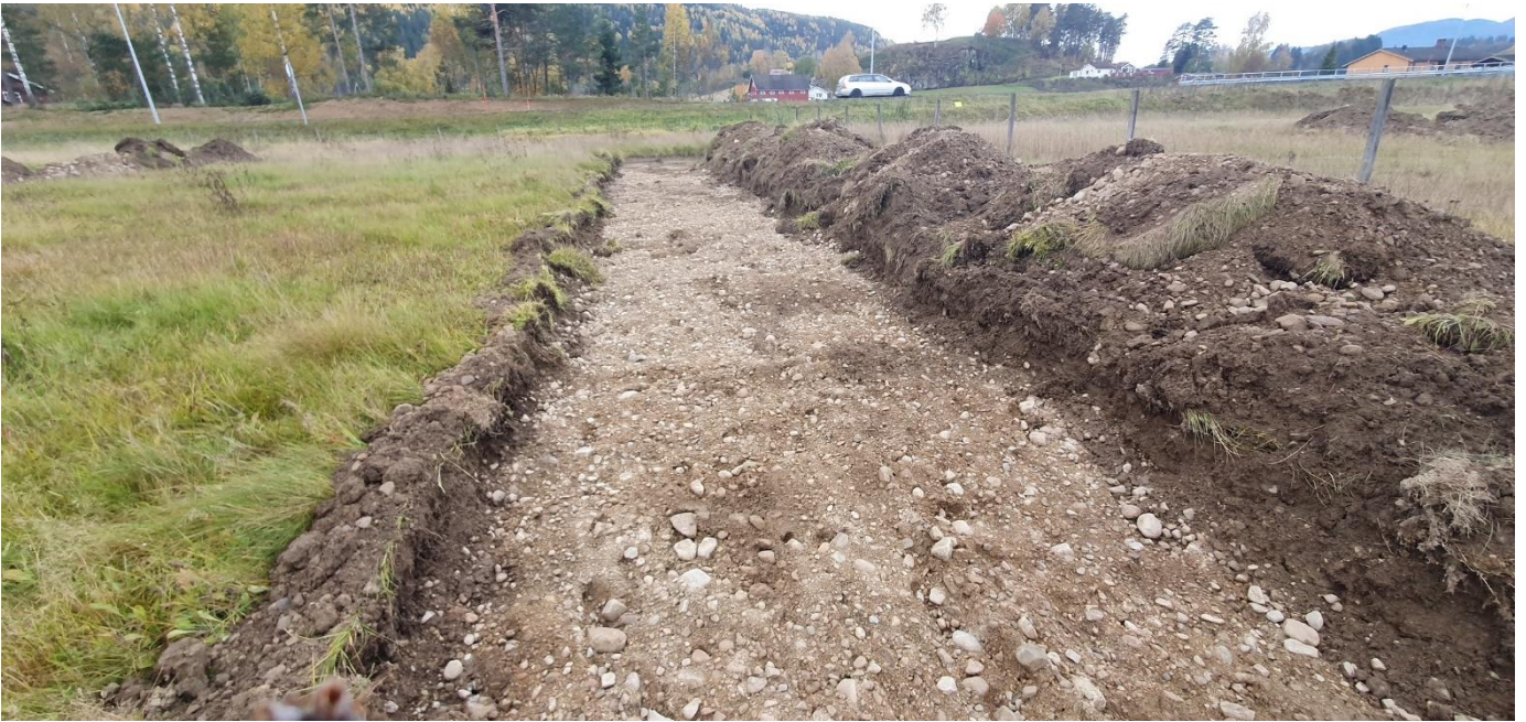
Bilde 4. Resultat fra graving av sjaktegrøfter.
