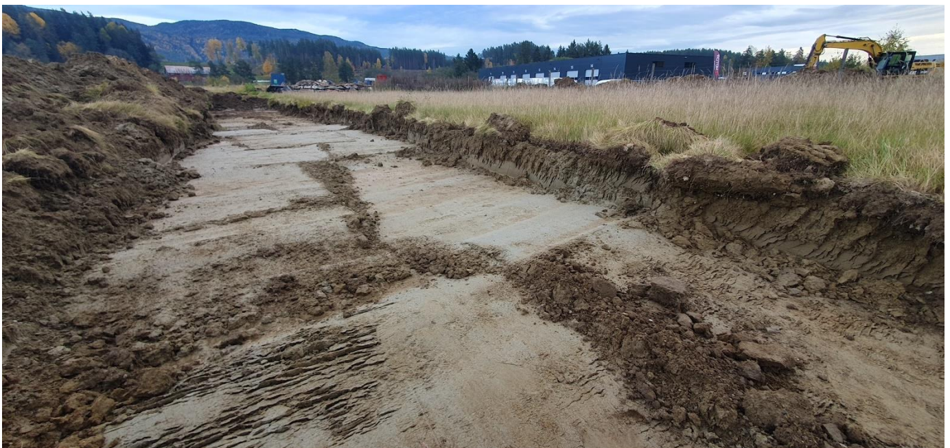
Bilde 3. Resultat fra graving av sjaktegrøfter.
