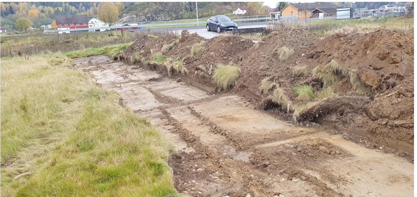
Bilde 5. Resultat fra graving av sjaktegrøfter.
