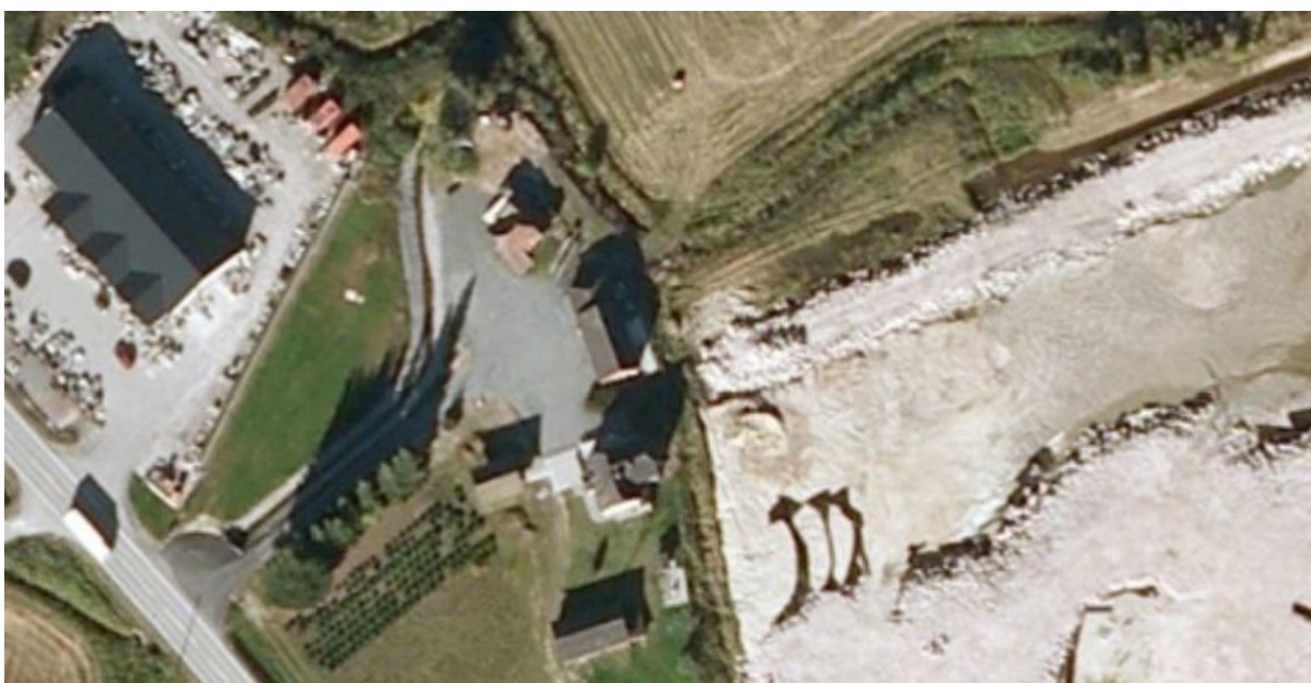
Figur 7. Flyfoto fra 2010. Oppfylling av Brenna næringsområdet er påbegynt (kart.1881.no).
