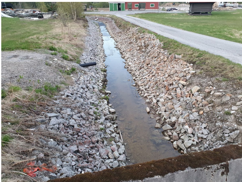
Figur 18: Foto av eksisterende modifiserte bekkeløp.
