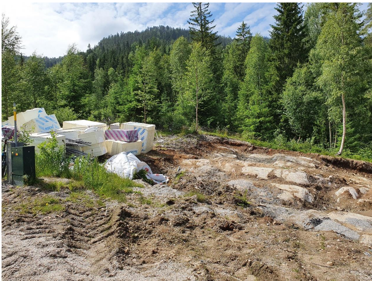
Figur 9: Utgravd tomt i planområdet. Synlig fjell under tynt dekke. Bilde tatt på befaring 25.06.2021
