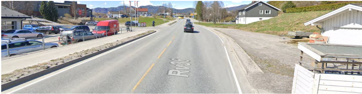
Figur 2-17: Breddeutvidelse av veibanen og en utkjørsel fra en enebolig ved innkjøring til planområdet. Foto: Google Street View.
