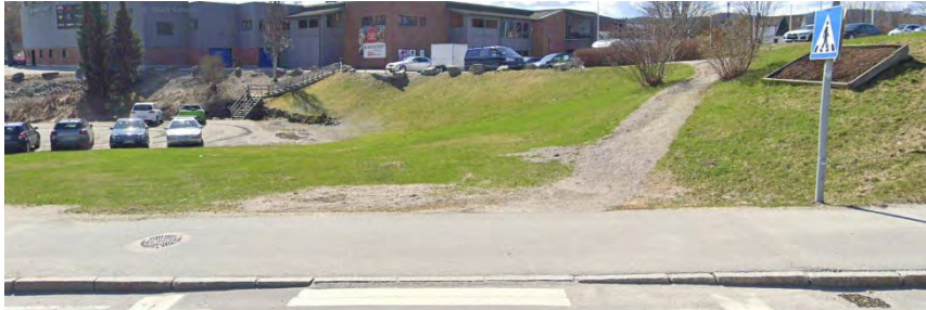
Figur 2-3: Trapp i bakkant og sti mellom Bøgata og senterets nivå. Foto: Google Street View, april 2023.
