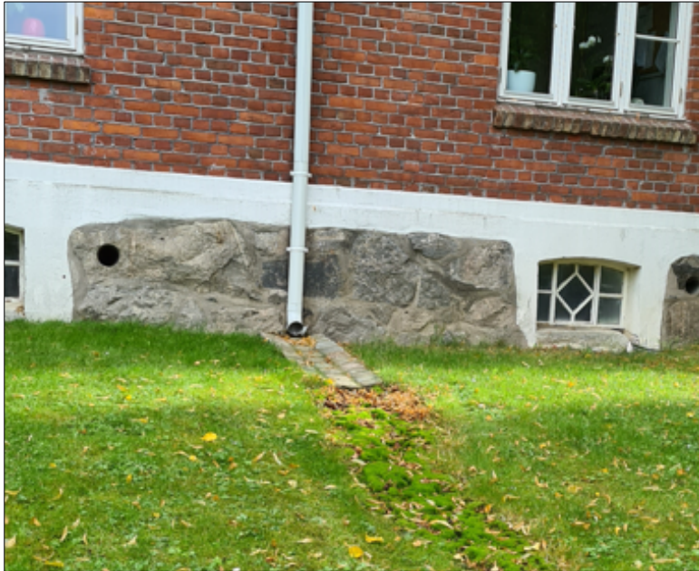
Figur 18: Takvann ledes ut på terreng/grøntområde. Foto: Jan Inge Rygh.
