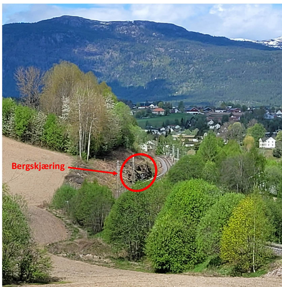
Bergskjæring langs jernbanen 350 m vest-nordvest for tomta
