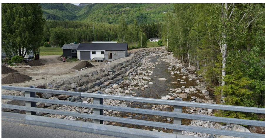
Figur 29: Elva Bjønndøla etter flaumsikringstiltaka blei bygd i 2024 (Google Street View, henta 2025).
