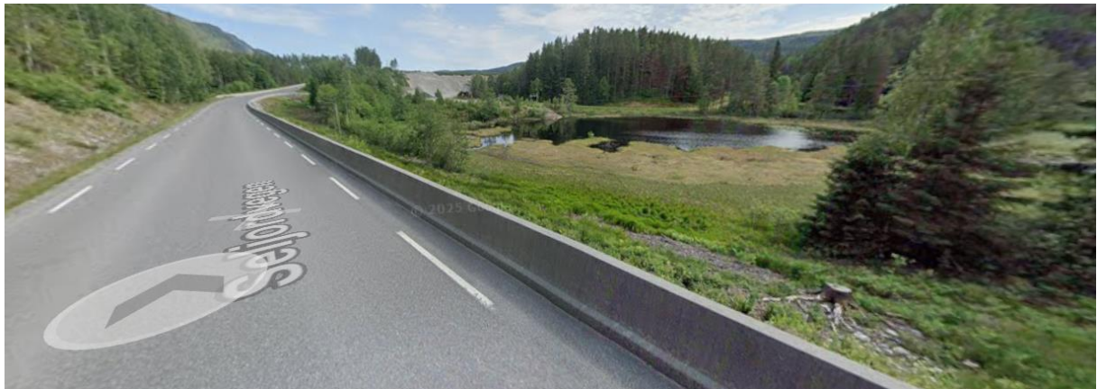
Figur 38: Betongrekkverk langs Rv. 36 hindrar avrenning av overvatn frå veg mot drikkevasskjelda ved Herretjønn. I bakgrunnen kan ein skimte Herremoen grustak.
